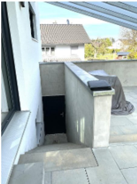
...Zugang zur Garage
