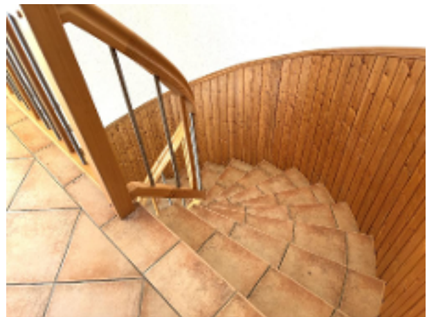
Treppe in das OG
