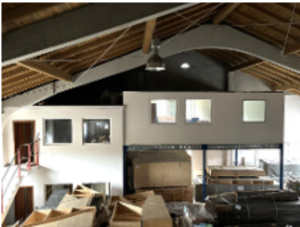
...Blick auf die Büroräume
